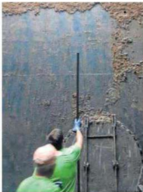
Limpieza de hidrantes y detalles de su estado. CANAL TORO-ZAMORA
